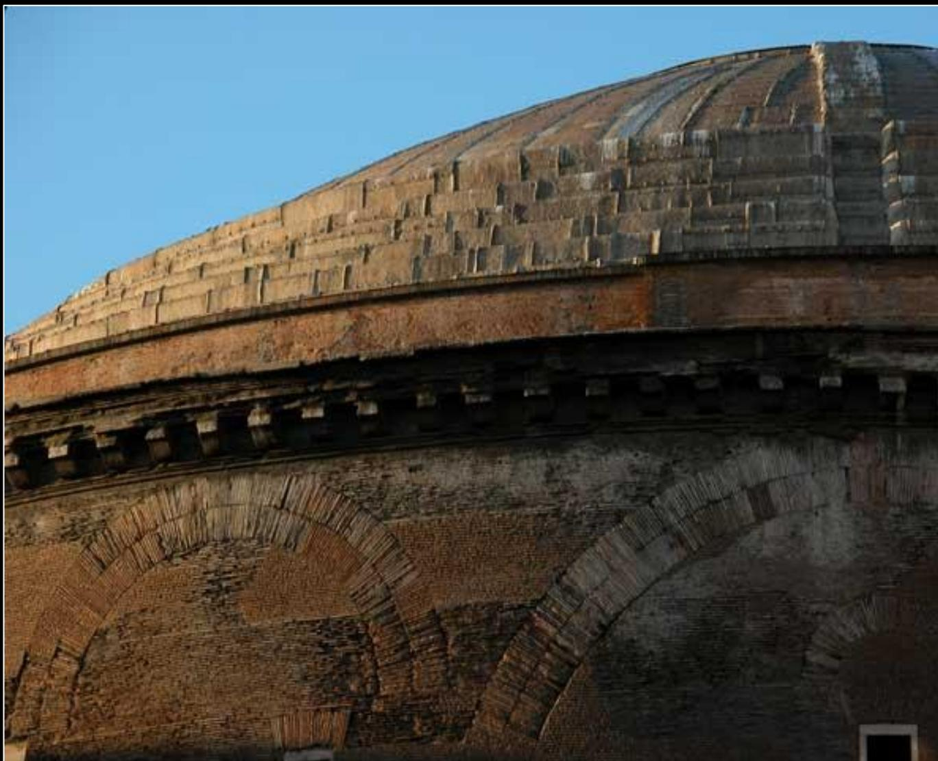
L'enorme CUPOLA (la più imponente dell'antichità, dal diametro di 43 metri) fu realizzata in OPERA CEMENTIZIA e presenta una serie di accorgimenti tecnici che ci testimoniano ancora una volta la grande abilità costruttiva dei Romani:
